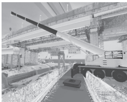
図-5 起工測量時の点群データ (福井コンピュータ株式会社提供)
